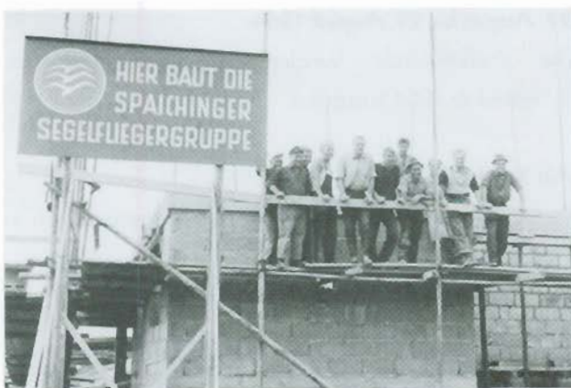
Der Bau wächst
