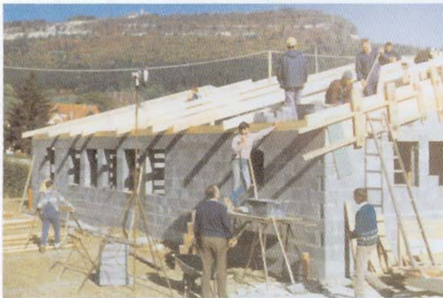
Der Rohbau ist nahezu fertig
